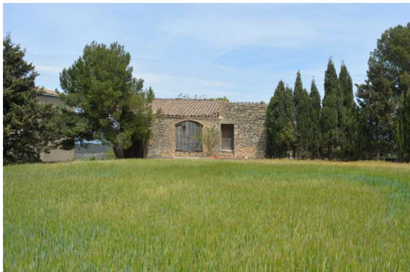
Partida: les Eres Any de construcció: 1891
